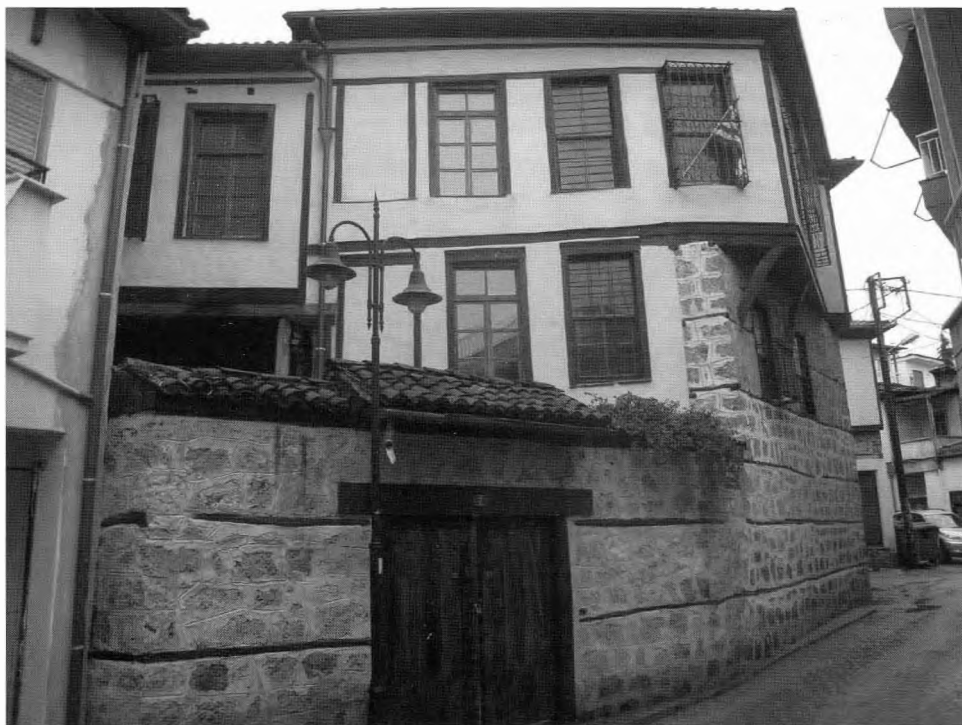
Όψη προς την οδό Σωφρονίου (κύρια είσοδος) μετά την αποκατάσταση.
