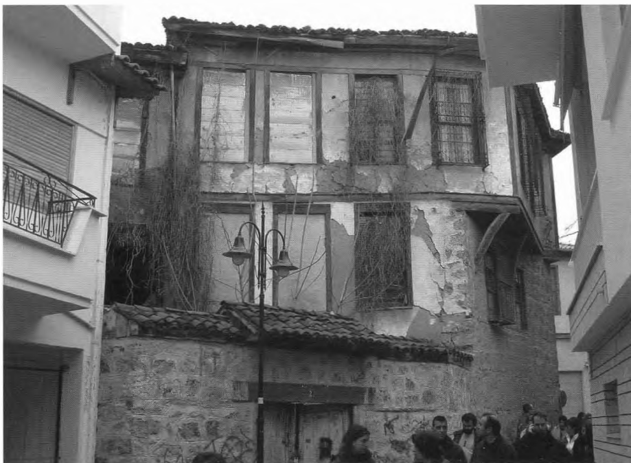
Όψη προς την οδό Σωφρονίου (κύρια είσοδος) πριν την αποκατάσταση.
