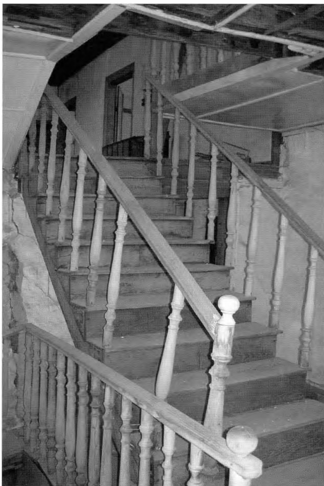
Η ξύλινη σκάλα για τον Β' όροφο
